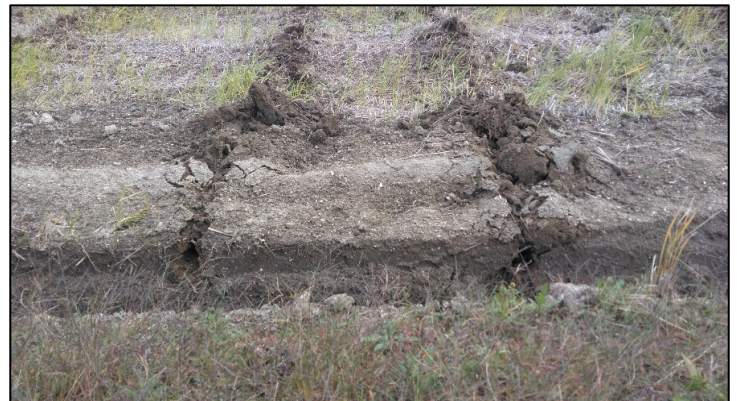
▼弾丸暗渠施工後
